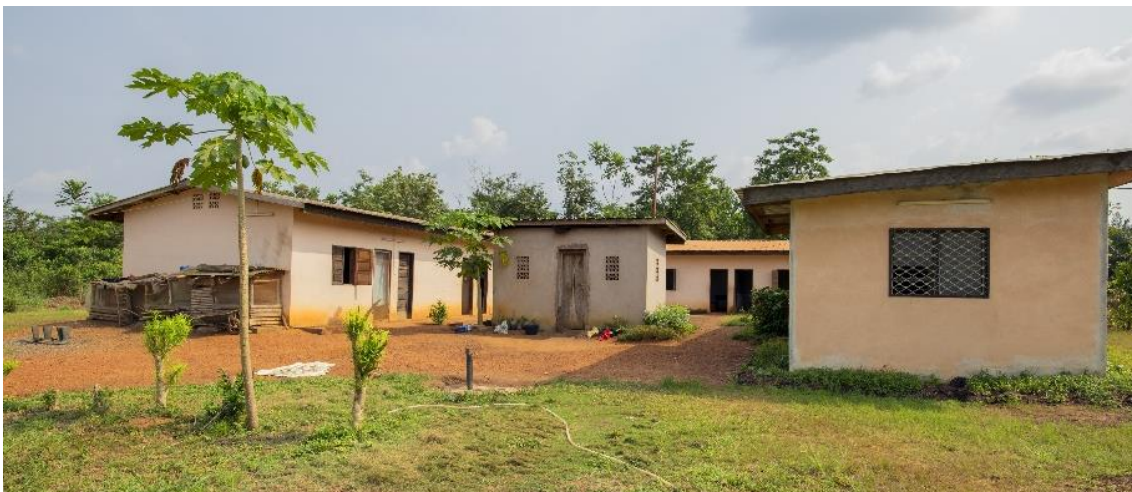
Figure 15 : Le bâtiment de l'école CFP-FA
