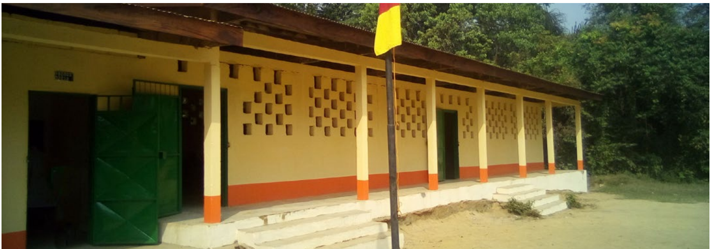
△ Réfection de l'école publique de Songueland, Safacam, Cameroun
