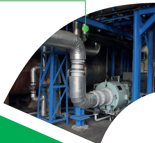
▽ Turbine à vapeur et chaudière à biomasse
