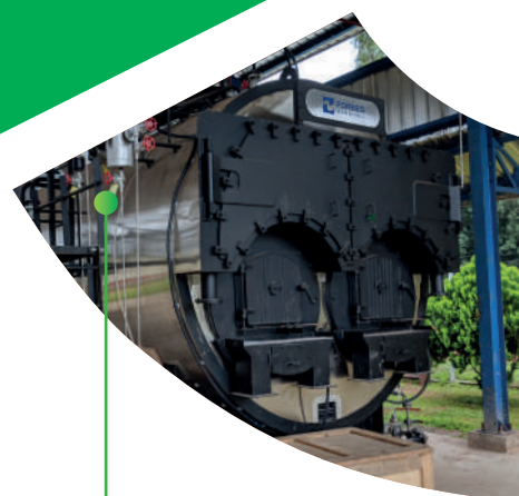
△ Chaudière pour séchoir à biomasse
