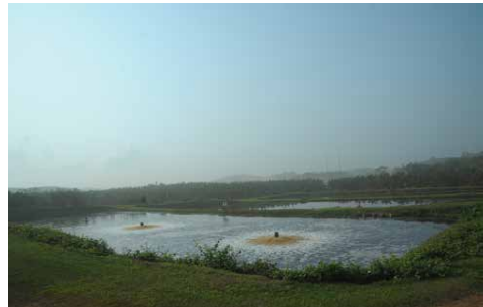
6.3.1 Aerator, SoGB, Côte d'Ivoire
