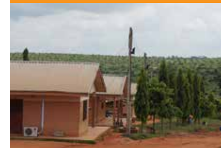
4.3.1.1 Electrification, Okomu, Nigeria
